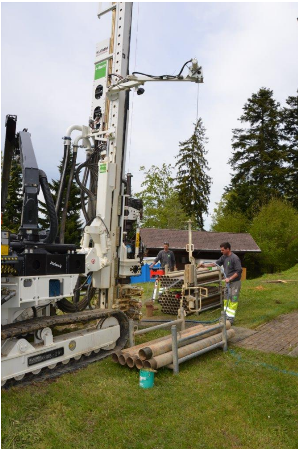
Bohrarbeiten für die Erdsonden
