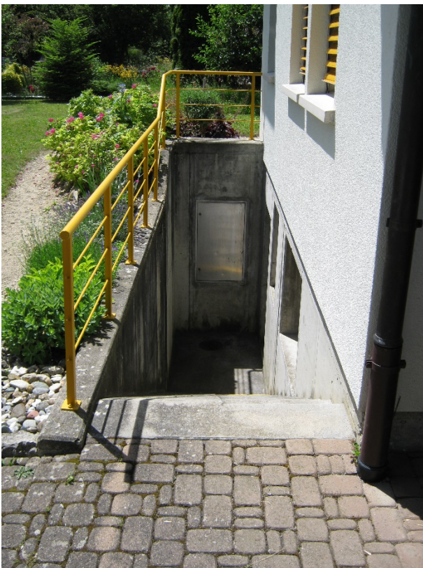
Einbringung durch die Kellerausstertreppe
