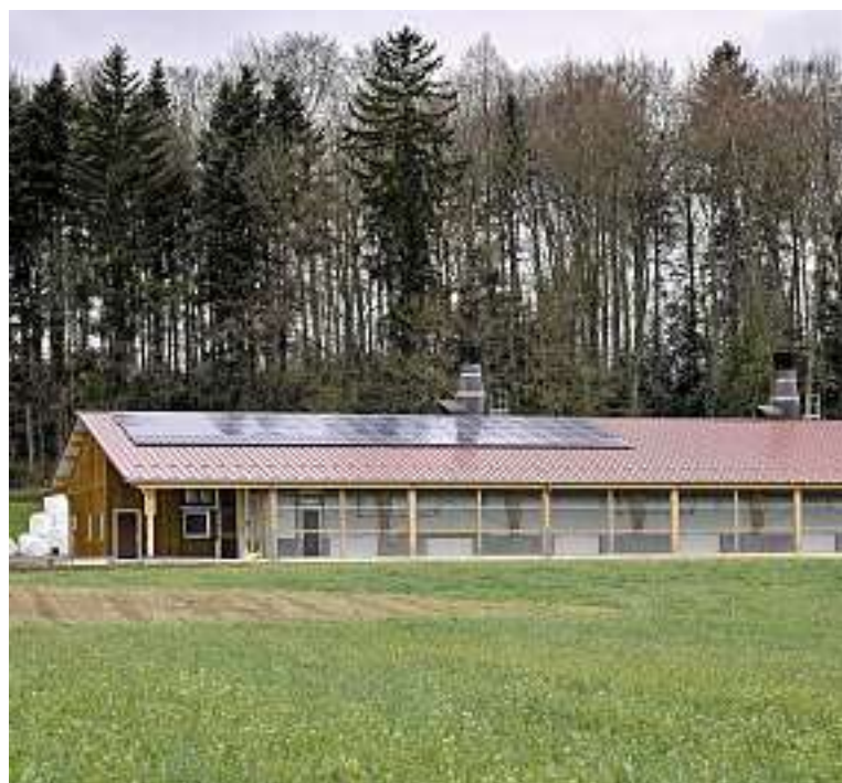
Kein Schadstoffausstoss: der Hühnerstall mit Solaranlage
