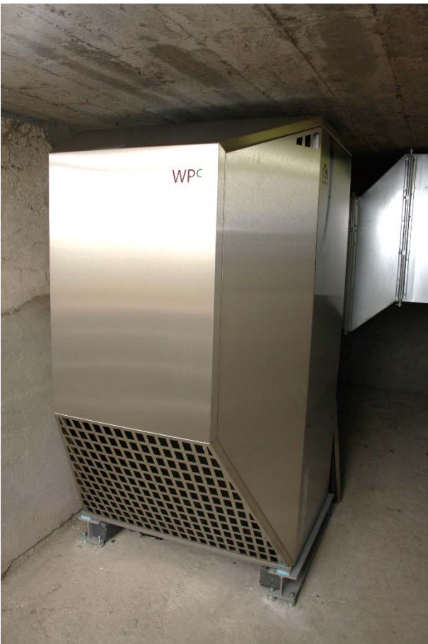
Anlage für Aussenaufstellung mit Ausblaskanal
