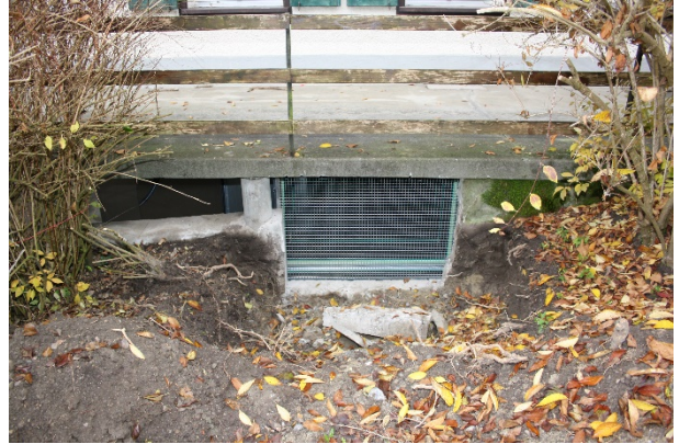
Ausblasöffnung mit Schutzgitter
